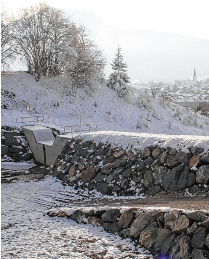
Dieses Becken oberhalb der Dummelsmoos-Siedlung soll Geschiebe und kleinere Muren auffangen. Unterhalb wurden zwei Leitdeiche errichtet. Foto: Michael Mang
