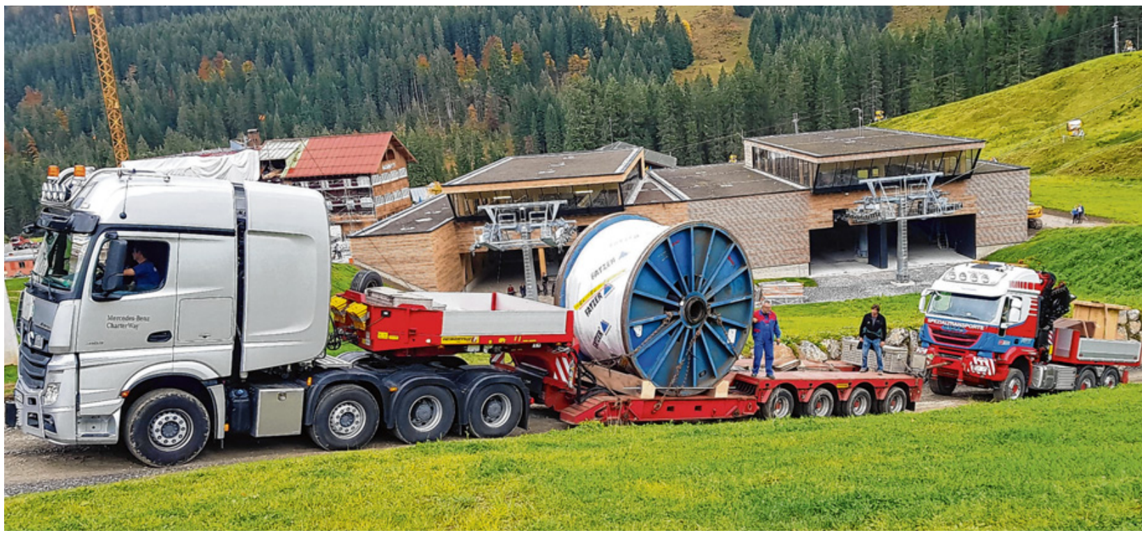
Die beiden über 70 Tonnen schweren Förderseile der neuen Kabinenbahn am Ifen sind mit Schwertransportern aus der Schweiz ins Kleinwalsertal gebracht worden. Sie werden in der kommenden Woche eingebaut. Die Bahn soll am 23. Dezember in Betrieb gehen. Foto: Jörn Homburg
