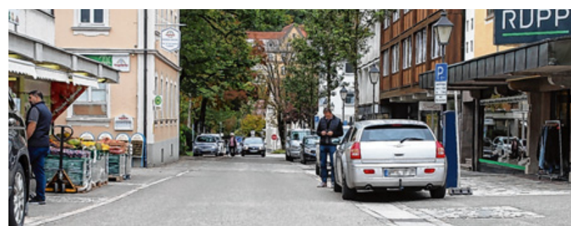
So wie in der Alleestraße soll auch die Bahnhofstraße in Immenstadt ausgebaut werden. Zumindest ist das der jüngste Beschluss des Stadtrats. Das bedeutet vorwiegend Asphalt, unterbrochen von Pflasterstreifen. Foto: Franz Summerer
